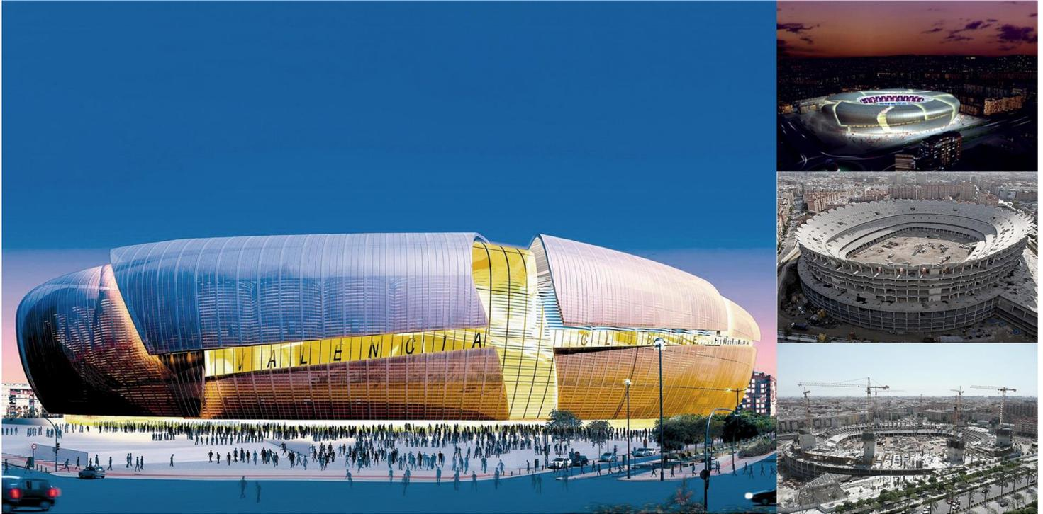
El Estadio se ubica en la Av. de las Cortes Valencianas y albergará a unos 75000 espectadores. La planta tiene forma elíptica con aparcamientos bajo rasante y tres niveles de gradas en la parte superior.
